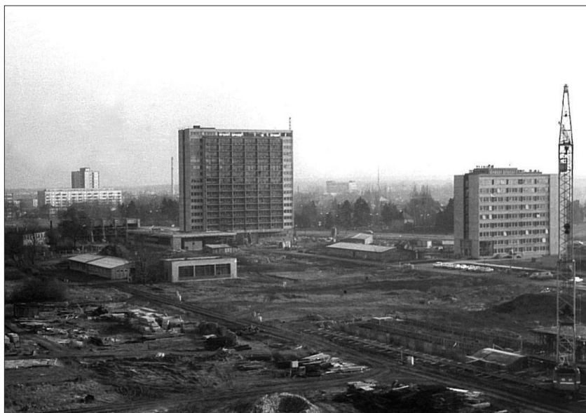
Obrázek č. 5. Pohled na staveniště s budovaným Novým internátem (polovina 70. let)
